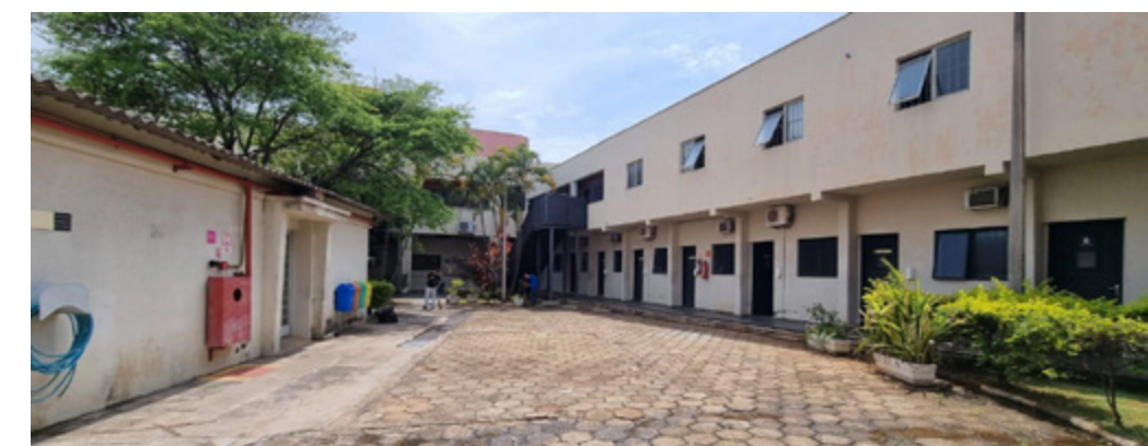
Situação pré-reforma da Unidade 1.
