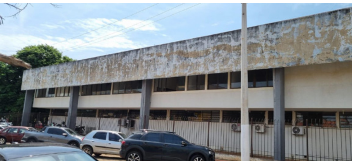
Situação pré-reforma da Unidade 2.
