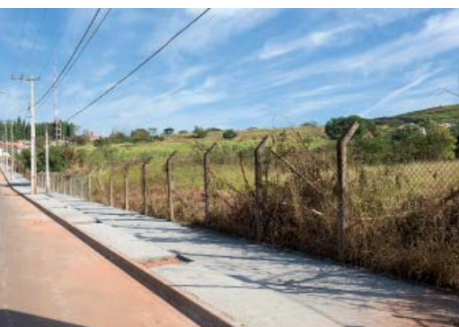
Obras na calçada do alojamento já foram concluídas
